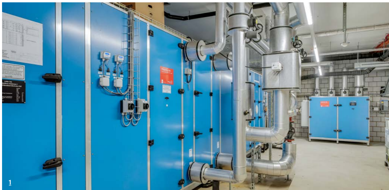
1 Blick auf einer der 7 Lüftungs-Monoblocke, welche das Laborgebäude mit hygienisch einwandfreier und temperierter Zuluft versorgen (Luftmengen Zufuhr von gesamt 164 000 m 3 pro Stunde).
