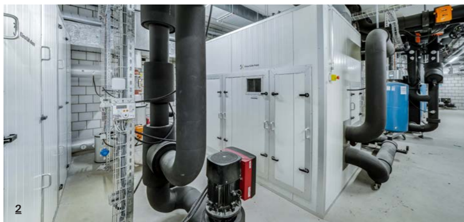
1 Blick auf einer der 7 Lüftungs-Monoblocke, welche das Laborgebäude mit hygienisch einwandfreier und temperierter Zuluft versorgen (Luftmengen Zufuhr von gesamt 164 000 m 3 pro Stunde).
